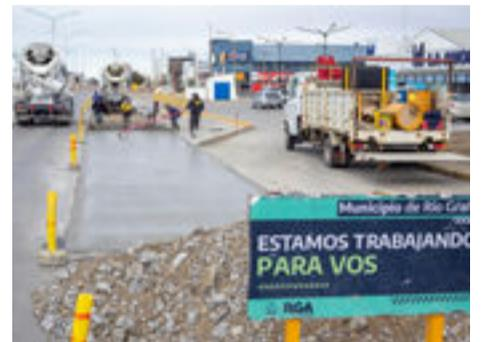
Se llevan adelante trabajos de hormigonado en pleno centro. Las labores implican la excavación de suelo, relleno y compactación, para el posterior vertido de hormigón en las distintas calzadas.
