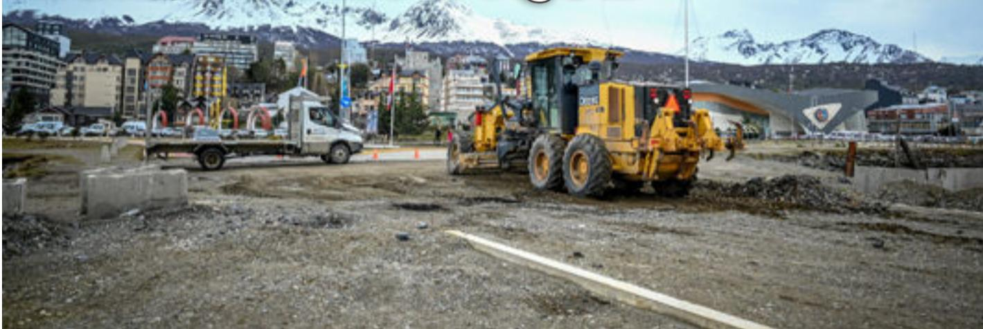
En el marco de la obra "Mejoramiento del Espacio Público", este lunes se trabajó con maquinaria, haciendo consolidación de suelo y acopio de material, para luego colocar adoquines en la calzada.
