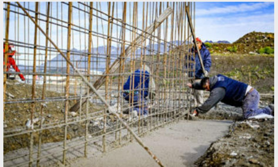
En el marco de los trabajos de puesta a punto de la planta productora de asfalto de la Municipalidad de Ushuaia, se inició el hormigonado del muro de contención de la rampa que servirá para la elevación de los áridos hasta la tolva de la máquina.
