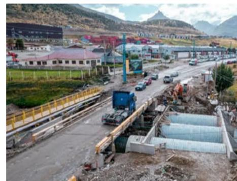
En octubre podría estar finalizada. Este fin de semana se demolió una parte del antiguo puente y se desvió la circulación vehicular hacia la parte nueva, además de la construcción de alcantarillas.
