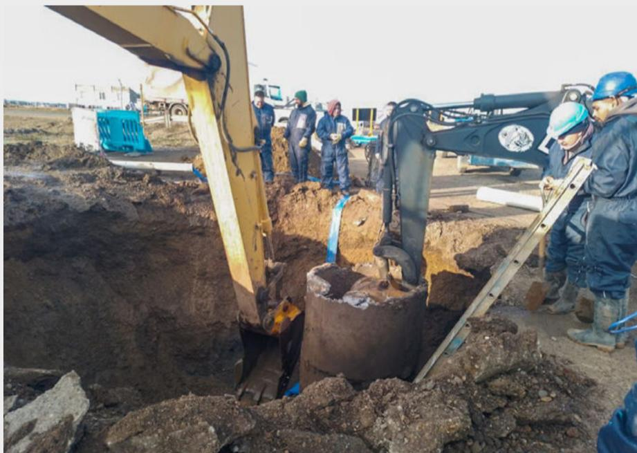
Trabajadores de Obras Sanitarias del Municipio se encuentran realizando la reparación de una cámara de cloacas en el barrio Los Cisnes. La misma conecta, también, los efluentes del B° Vapor Amadeo.
