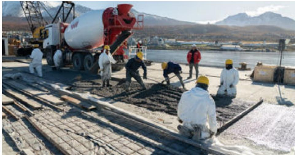
Se hormigonó parte de la carpeta de rodamiento, y se está a la espera de la llegada de la armadura para las defensas y los postes de amarre.
