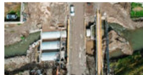
Se espera que fragüe el nuevo hormigón, para demoler el puente viejo sobre ese sector. Además, avanzan en el sector aguas arriba, donde se están colocando las alcantarillas.
