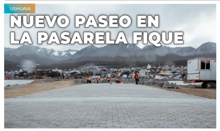
Ya se hizo movimiento de suelo para comenzar con el hormigonado y ejecución de cordón, para contención de la calle de adoquines. También se construyen reductores de velocidad.
