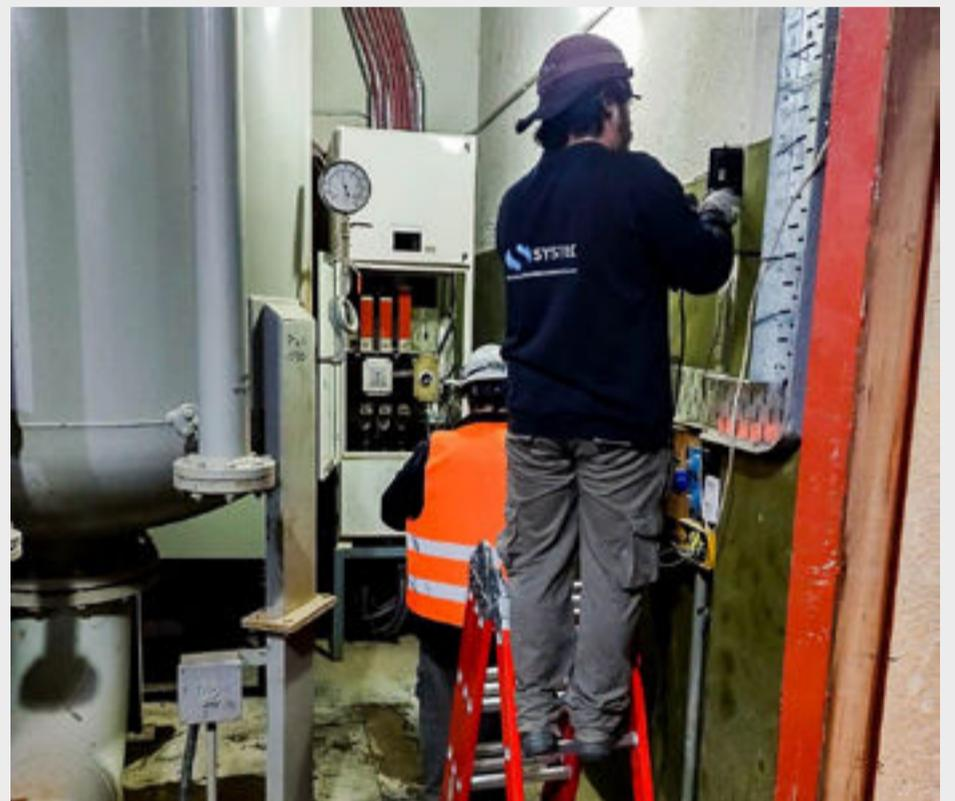
Se trata de la instalación y puesta en funcionamiento de un nuevo tablero de transferencia en la Planta Potabilizadora N°3 "Gran Malvina", en el marco del plan de mejora continua del servicio de agua potable.
