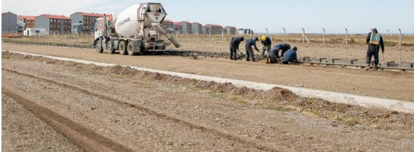
Se trata de un kilómetro de extensión, que también contempla una bicisenda. Se realizan los trabajos de movimiento de suelo para la posterior pavimentación asfáltica, además los cordones cuneta.
