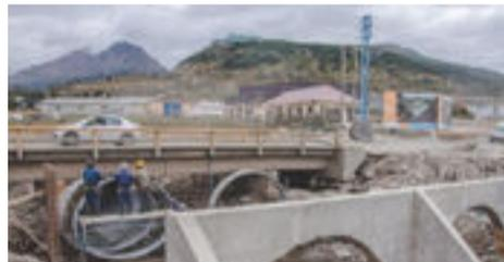
Se están llevando adelante los trabajos de armado, preparación y nivelación de dos alcantarillas, como así también la construcción del muro de contención del alcantarillado y del puente.
