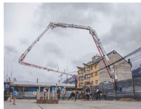
Ya se terminaron los desagües, el hormigonado y fundaciones, ahora se levantarán las columnas de estructura metálica que conformará el edificio de Defensa Civil y el Centro de Monitoreo Urbano.
