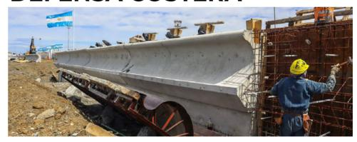
Obras Públicas Municipal, permanece interviniendo en la zona costera con el levantamiento del muro que tiene previsto recorrer 1 kilómetro de la línea límite de la ciudad, a los fines no solo de protegerla del impacto del oleaje y los puntos de rompimiento del mismo, sino también en la protección de su patrimonio histórico como lo es el Monumento a los Caídos de Malvinas.
