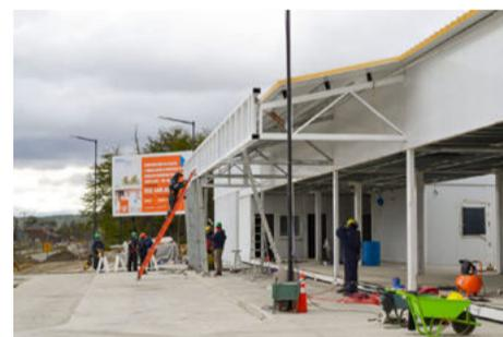
Se está finalizando el cerramiento del espacio, así como trabajos de instalación de datos, de electricidad y de extinción y detección de incendios. El lugar tendrá espacios para la atención de emergencias.
