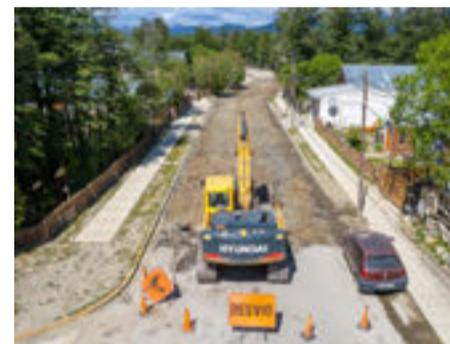
Comienza el proceso de demolición de la calzada, el primer paso para llevar adelante los trabajos de reasfaltado y pavimentación.
