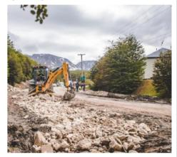
Se levantó el asfalto que estaba en malas condiciones y se reconstruyó el suelo con material nuevo. También se excavaron cunetas para drenaie.
