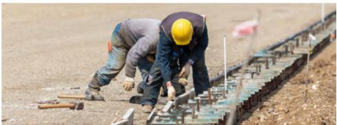
El Municipio inició con la construcción de 1200 metros de cordón cuneta en ambos sentidos de la extensión de la Av. San Martín, con el fin de preparar el terreno para su correspondiente pavimentación.
