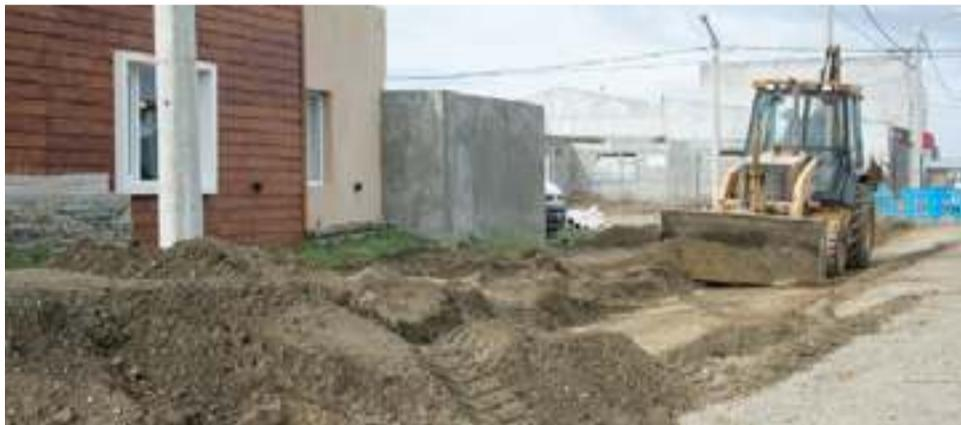
Los trabajos incluyen la limpieza de cámaras cloacales. A partir de esta obra, se descomprimirán las redes cloacales de la zona y de esta manera, se evitará la saturación del sistema.
