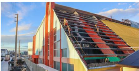
Los trabajos actuales consisten en el recambio integral de la cubierta, con los trabajos del segundo tramo del techo y de pintura.
