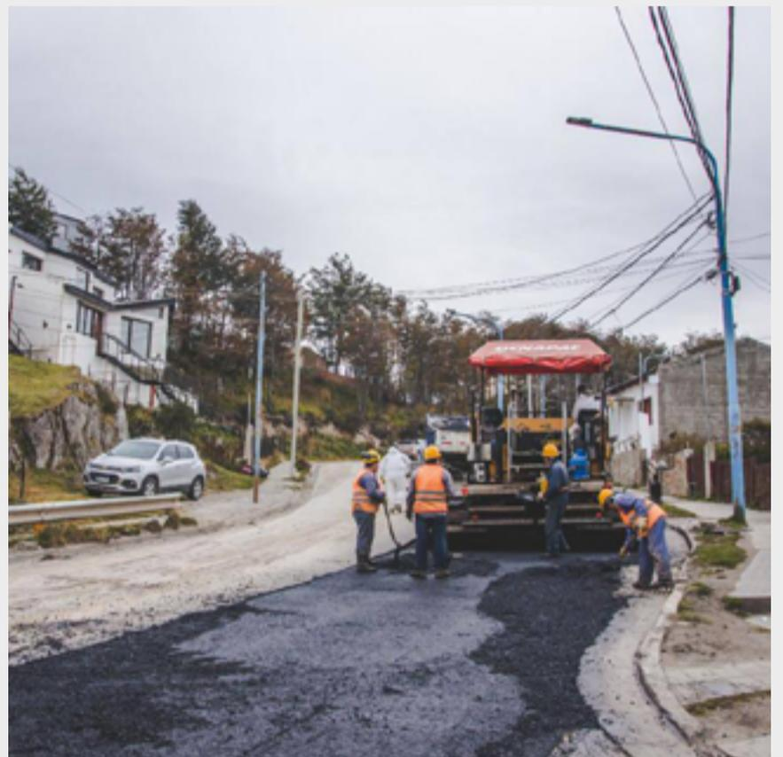
En el marco del Plan de Obras de la Municipalidad de Ushuaia, se avanzó en la colocación de asfalto en caliente en la calle Eva Perón.
