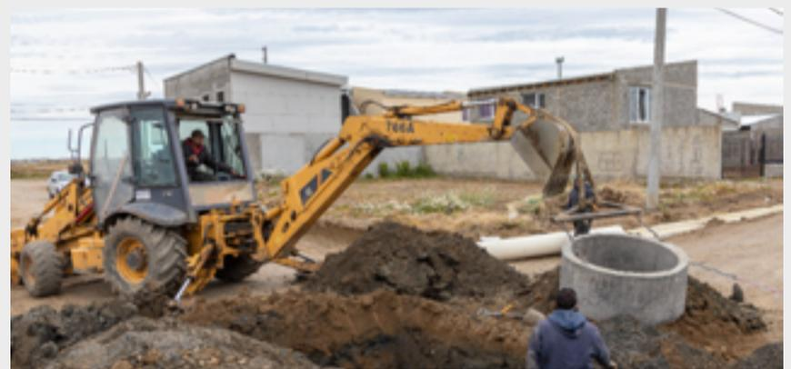
Los trabajos consisten en la instalación de sumideros con el fin de recolectar el agua de los cordones cunetas para luego conectarlos a la red del B° Malvinas Argentinas y conducirlos al Río Grande.
