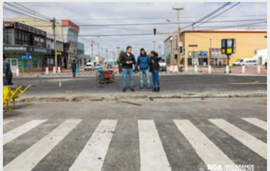
La misma estará habilitada el próximo martes. Anteriormente, se removieron adoquines y, en el día de la fecha finalizó el vertido de capas asfálticas para llegar al nivel de la intervención original. El Municipio lleva adelante un importante Plan de Obras para dotar a la ciudad de infraestructura vial acorde a su crecimiento que, su vez, genere un entorno urbano seguro para los vecinos.
