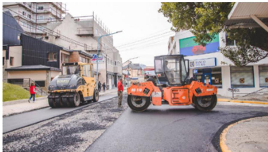
Continuaron los trabajos de repavimentación en la calle San Martín donde este viernes colocaron pavimento en el tramo comprendido entre Onas y Belgrano, luego de realizar los trabajos de fresado y preparación de la calzada.
