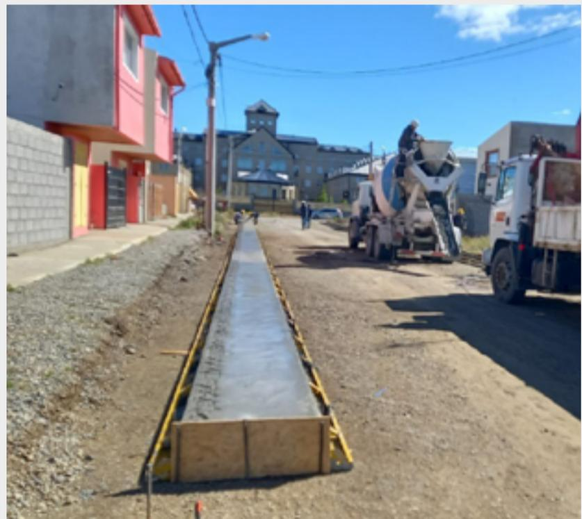
Se trata de la construcción de cordón cuneta en diversas calles de ambos barrios, lo cual permitirá el correcto drenaje de las calzadas y la vinculación de las mismas al sistema pluvial de las zonas.
