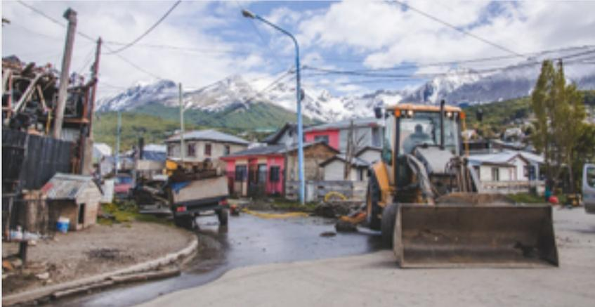
En el marco del plan de obras de la Municipalidad de Ushuaia se realizan trabajos para la construcción de una boca de tormenta en la bocacalle de Acigami y Francisco González, para resolver la retención de agua que se producía en el lugar.
