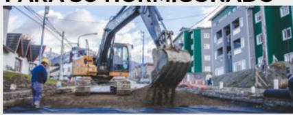
Este miércoles en la calle Formosa, en el tramo próximo a la intersección con la avenida Hipólito Yrigoyen, la empresa que lleva adelante la obra de pavimentación realizó un trabajo de mejoramiento de la subrasante mediante la colocación de pedraplen y geotextil, que permitirá el volcado de hormigón.
