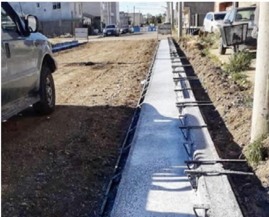
Se trata de la construcción de cordón cuneta a lo largo de la calle Kovacic. Para ello, se está trabajando en el recambio y movimiento de suelos para luego asentar el cordón cuneta propiamente dicho, lo que permitirá el correcto drenaje de la calzada y la vinculación de la
