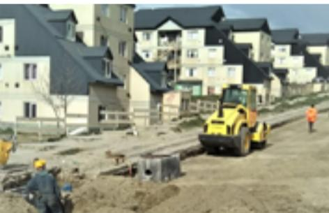
La Municipalidad de Ushuaia lleva adelante los trabajos programados para la pavimentación con hormigón de la calle De la Estancia, en el barrio Pipo. Se realiza el tenido de pluviales para luego continuar con el hormigonado de las calles.
