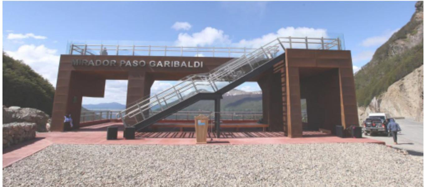
de las rocas cercanas, creando una película impermeable al agua y al vapor, que impide que la oxidación del acero prosiga hacia el interior de la pieza.
