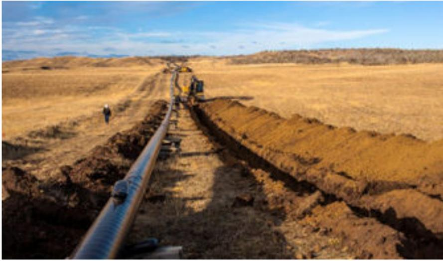
RÍO GRANDE. Esta obra de infraestructura energética contempla la ejecución de distintos loops en cañerías de 12, 6 y 3 pulgadas de diámetro con una extensión total de 29.000 metros. Adicionalmente, se instalará un nuevo equipo de compresión en la Planta Compresora de Tolhuin.
