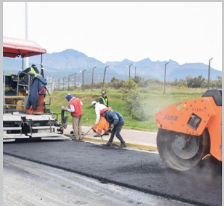
USHUAIA. Luego de los trabajos en todo el tramo de la avenida Hipólito Yrigoyen, entre Malvinas Argentinas y Perón sur, la empresa contratista realizó este viernes la pavimentación con asfalto en caliente en todo el ancho de la calzada.
