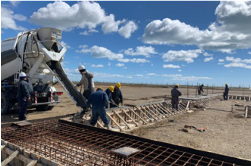
RÍO GRANDE. En el marco de la obra 'Planta de Tratamiento de Efluentes Cloacales-Margen Sur-Río Grande', la Dirección Provincial de Obras y Servicios Sanitarios realizó de movimiento de suelo, en particular terraplén compactado en la zona donde serán implantados los reactores y llevó a cabo el hormigonado de las vigas de fundación de la nave de sopladores.
