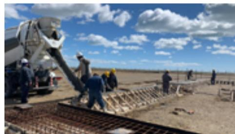
En el marco de la obra 'Planta de Tratamiento de Efluentes Cloacales-Margen Sur-Río Grande', la Dirección Provincial de Obras y Servicios Sanitarios (DPOSS) realizó el movimiento de suelo para iniciar el hormigonado de las vigas de fundación de la nueva edificación.
