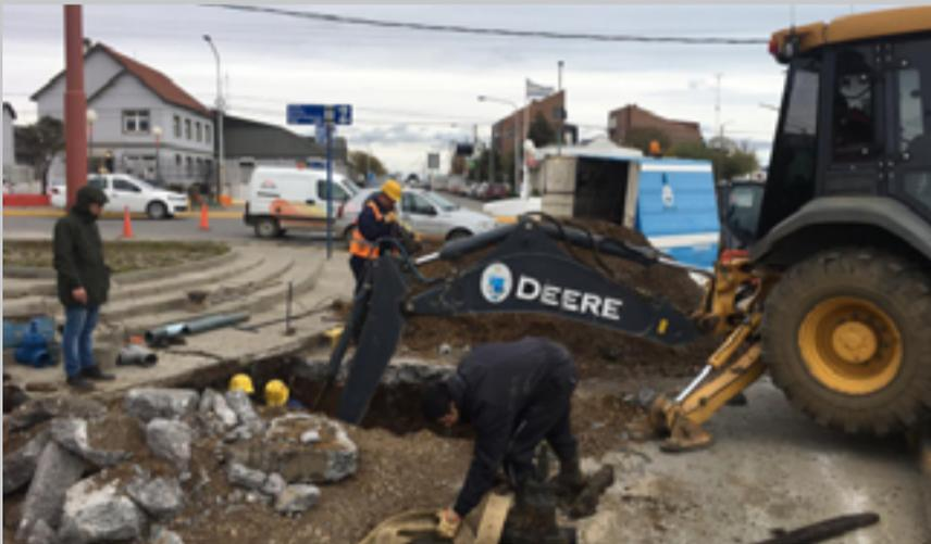
RÍO GRANDE. El operativo se realizó esta mañana para renovar una válvula de cierre de vieja data, que presentaba un deterioro significativo e impedía que el agua fluya correctamente.
