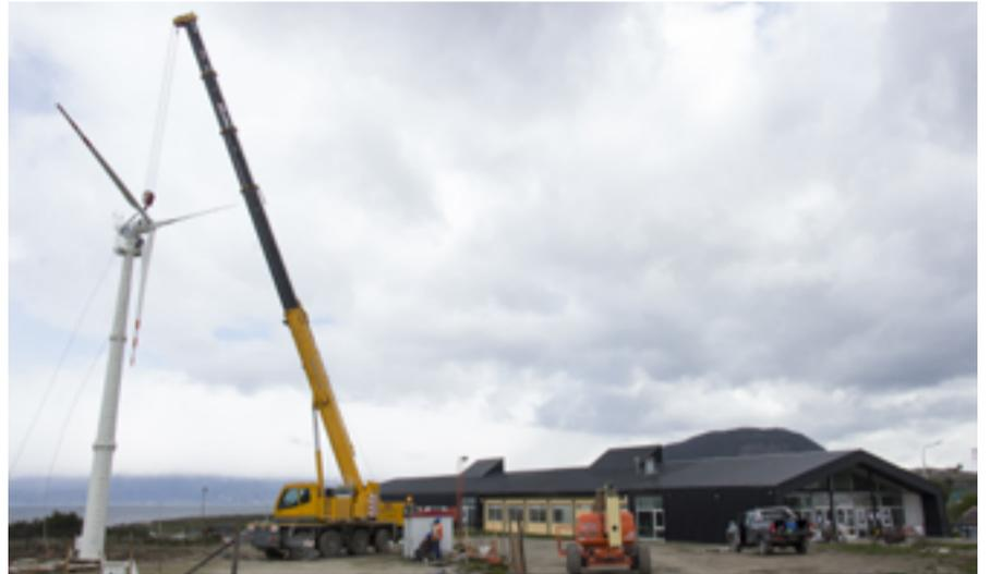
12m/s en promedio. Se trata de un equipo robusto, con una torre monoposte de 16 metros de altura, un rotor de 18m de diámetro y un peso estimado de 10 toneladas.
